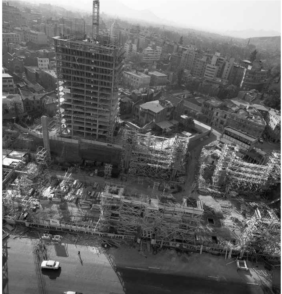
Construcción del edificio UNCTAD III, hoy re- nombrado como Centro Gabriela Mistral (GAM). Jack Ceitelis, 1971
