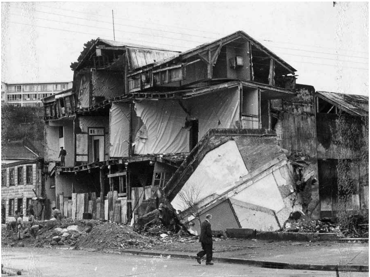
Vivienda con daños en Puerto Montt por efectos del terremoto de 1960. Atilano Lamana Pola, 1960
