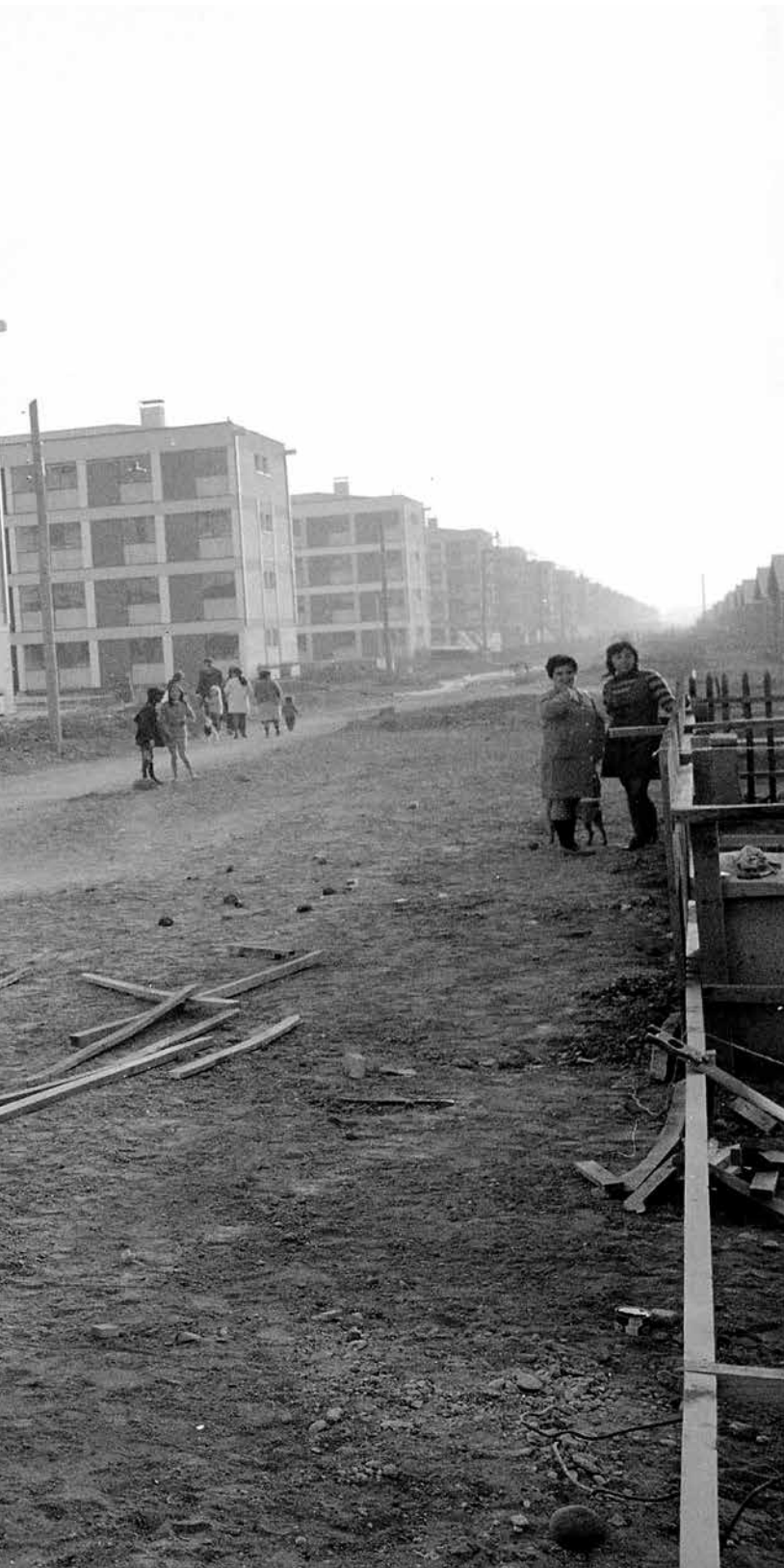
Conjunto de edificios de departamentos CORVI, poco después de terminada su construcción. Jack Ceitelis, 1972
