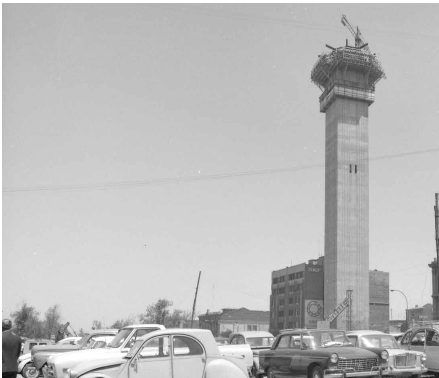
Construcción de la Torre Entel. Jack Ceitelis, 1973
