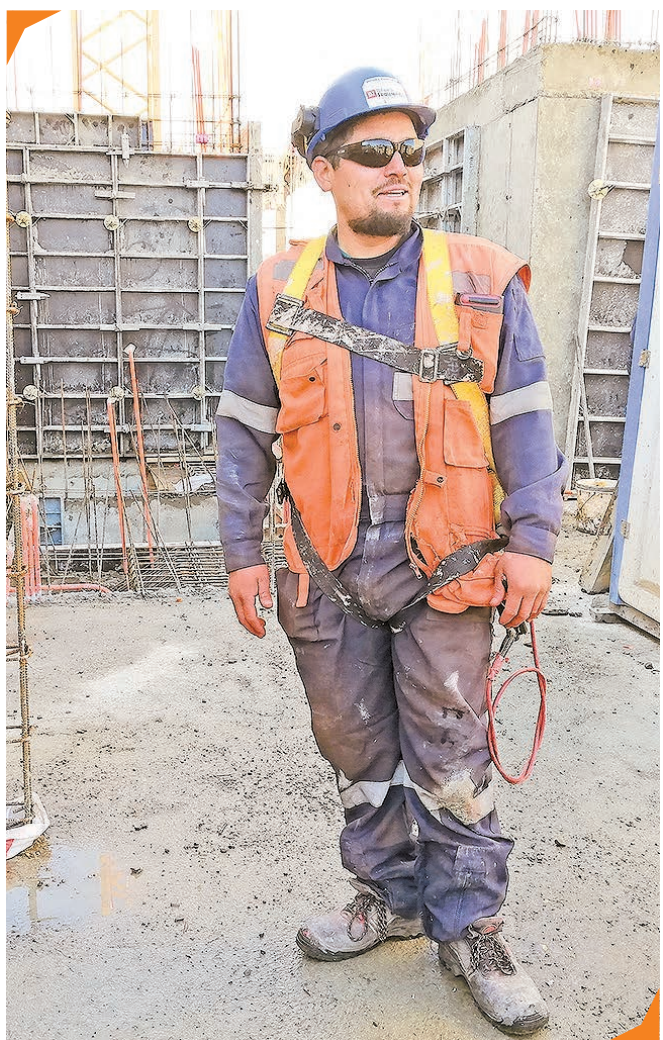
Miguel Angel Sánchez está a cargo del trazado de obras en esta construcción que lleva adelante Bravo & Izquierdo, en la ampliación del Hotel Rey don Felipe.
