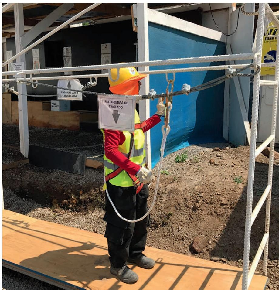
Imagen del circuito de entrenamiento práctico de “Aprender Ejecutando” de Echeverría Izquierdo Edificación. En este caso, busca instruir a los trabajadores sobre el uso correcto del arnés de seguridad y el posicionamiento en la plataforma de trabajo en altura.
