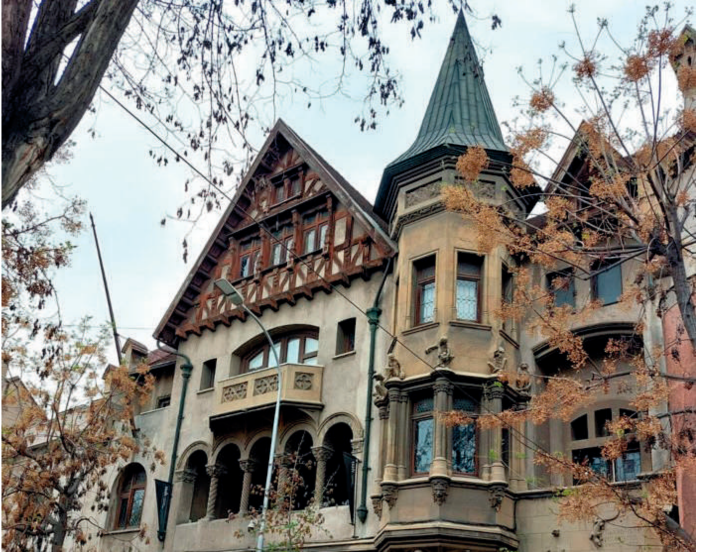
La limpieza de las fachadas de la Universidad Alberto Hurtado se hizo con hidroarenado, una técnica que aplica agua con presión mezclada con una arena fina.
