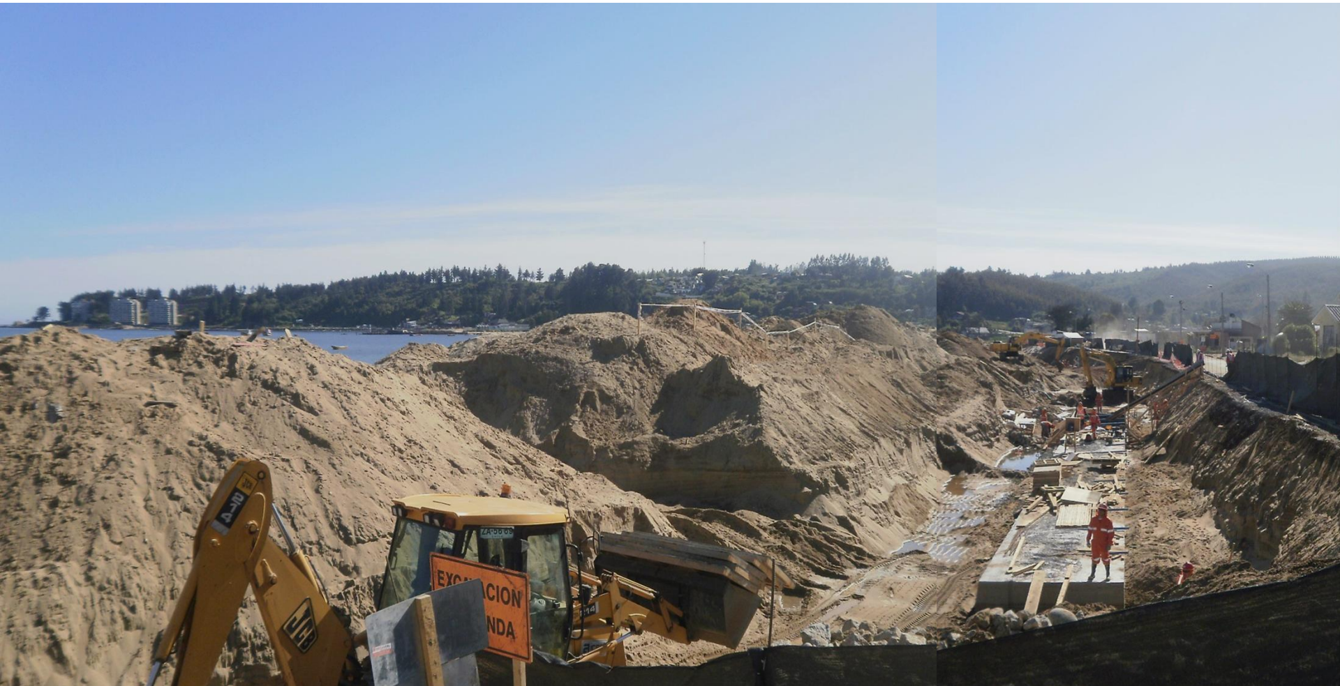
Ejecución Costanera Dichato 2011
