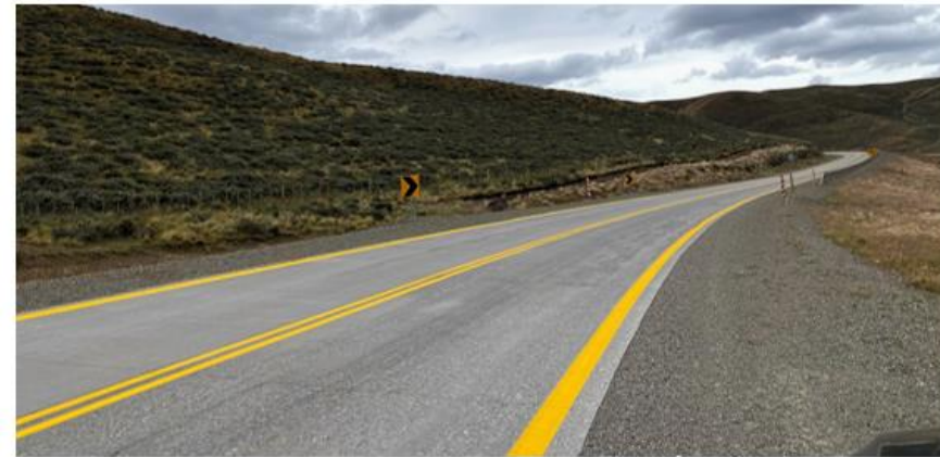
Mejoramiento Ruta 257-CH, tramo III. Km 86,500. Estancia Miriana. Fuente: Elaboración propia.
