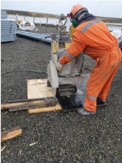
Extracción de testigos, aserrado y embalaje. Ruta Y-65 tramo 2. Fuente: Elaboración propia.
