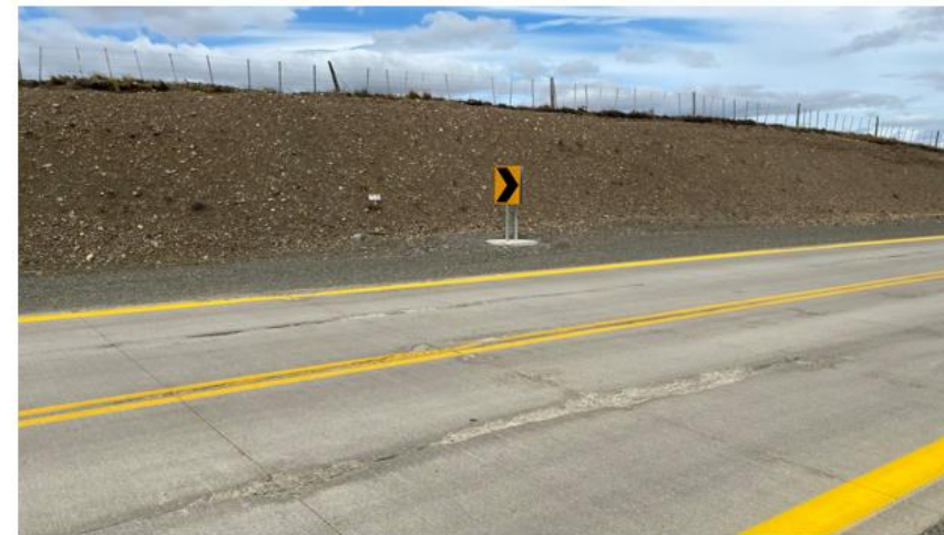
Mejoramiento Ruta 257-CH, tramo III. Pavimento delgado de geometría optimizada y fibra. Fuente: Elaboración propia.
