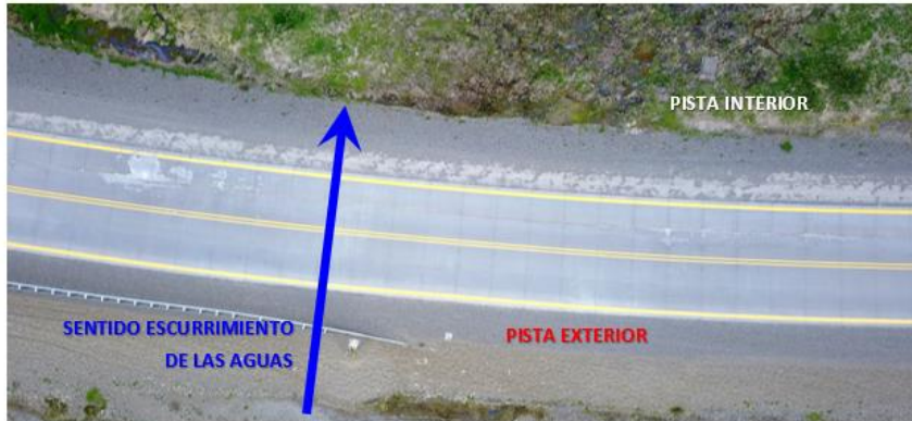
Mejoramiento Ruta 257-CH, tramo II. Inicio km 58,800 al km 78,000. Fuente: Elaboración propia.
