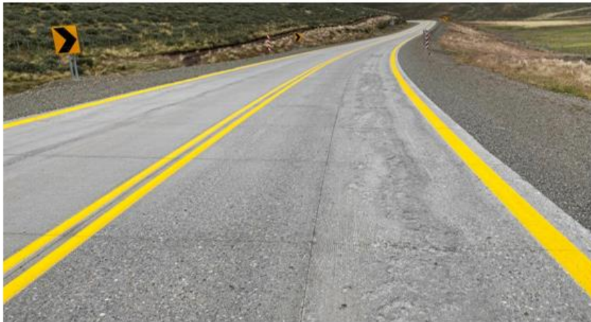
Mejoramiento Ruta 257-CH, tramo III. Inicio km 15,300 hasta km 58,800. Fuente: Elaboración propia.
