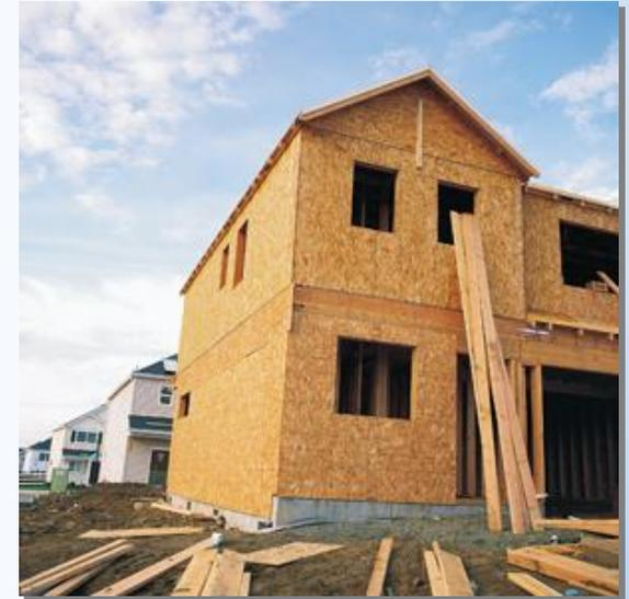
LP fabrica el tablero estructural mas vendido del mundo. LP OSB ha sido usado en el mercado internacional de la construcción por mas de 3 decadas y es conocido por su **uniformidad, dureza, densidad y trabajabilidad.**
