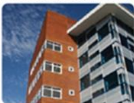
EDIFICIO POLICIA DE INVESTIGACIONES, P. MONTT
