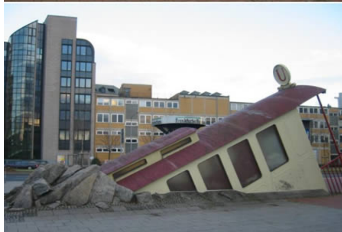
Estación de Metro Bockenheimer, en Frankfurt
