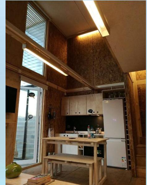
La Línea utilizada fue nuestra Línea Europea Softline 58 DJ que por su configuración de doble contacto, son óptimas en estanquidad y hermeticidad, donde posee un valor U de **1.8 W/m<sup>2</sup>K**. Además incorporamos termopaneles con cristales Lirquén, Low-E para todos sus recintos.
