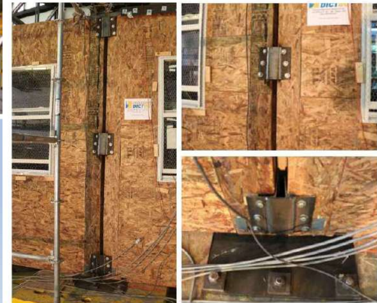
Figura No. 47 – Conectores rígidos entre muros del sentido transversal.
