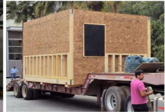
Figura No. 48 – Módulo Prefabricado de 3.54x4.72x2.86m.
